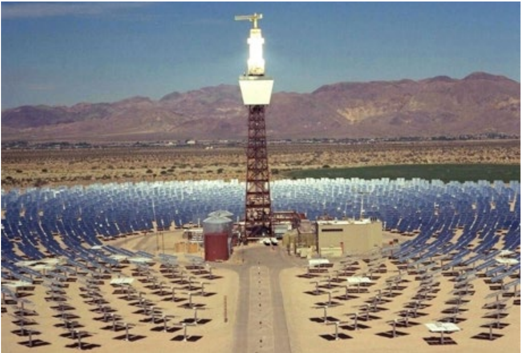
Figura 11. Torre Central instalada na Califórnia, EUA
