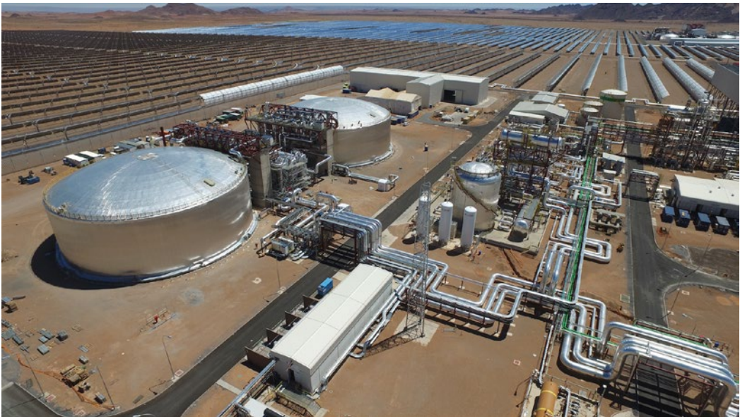
Figura 23. Sistema de armazenamento térmico (indireto) de sal fundido com dois tanques com capacidade de cinco horas em uma planta de Calha Parabólica de 100 MW. Fonte: SolarPaces (2020)
