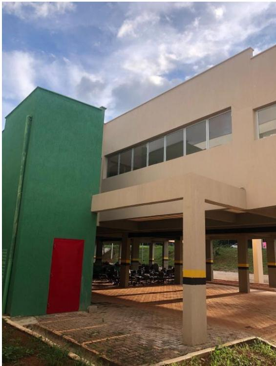
Vista do local a ser inserido elevador e escada. Em destaque, janelas do pavimento superior que serão removidas para integração dos espaços.
