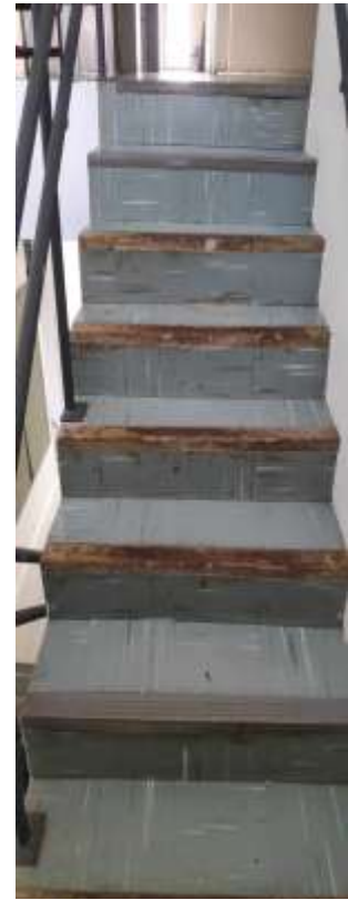
C. Fotografia do vão superior da escada realizada no patamar intermediário.
