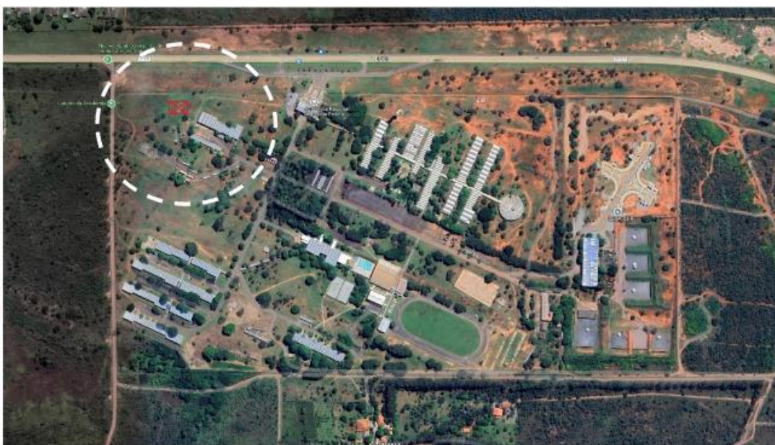
Figura 1 – a) vista área da área que receberá a infraestrutura da sala de testes de coletes á prova de balas
