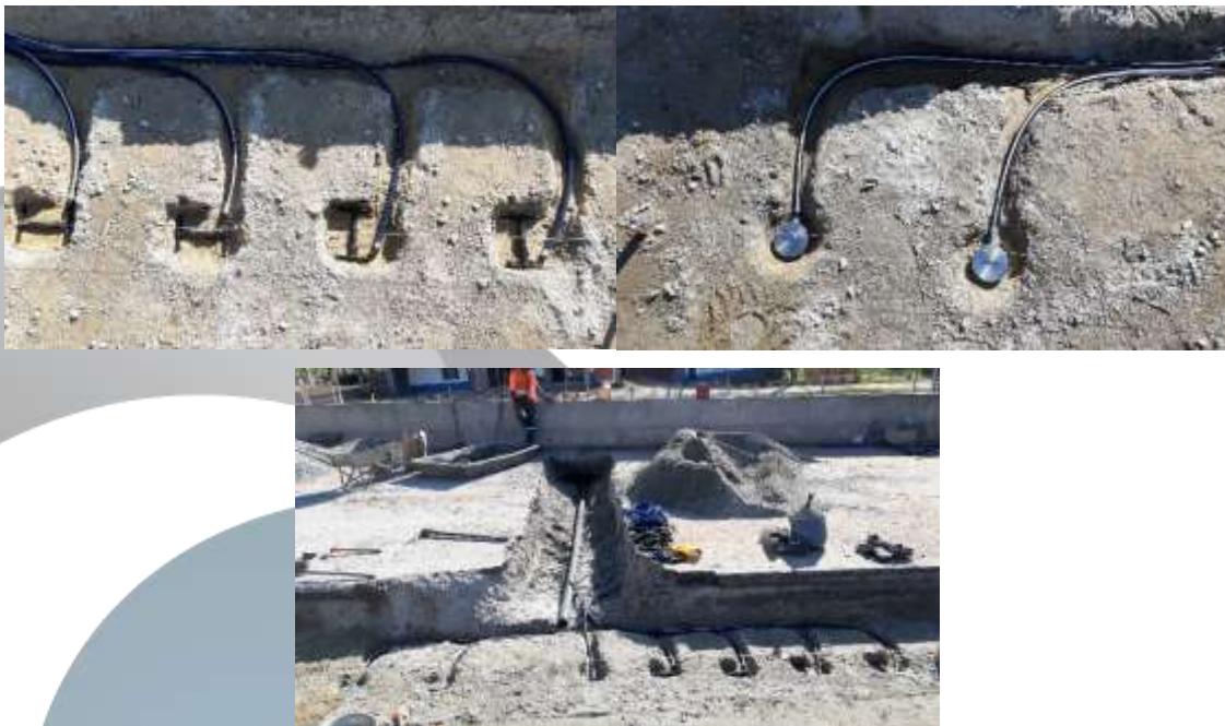
Figura 18 – Detalhes das trincheiras para o posicionamento de instrumentos e passagens de cabos e eletrodutos em pavimento rodoviário e (Silva et al. , 2019).
