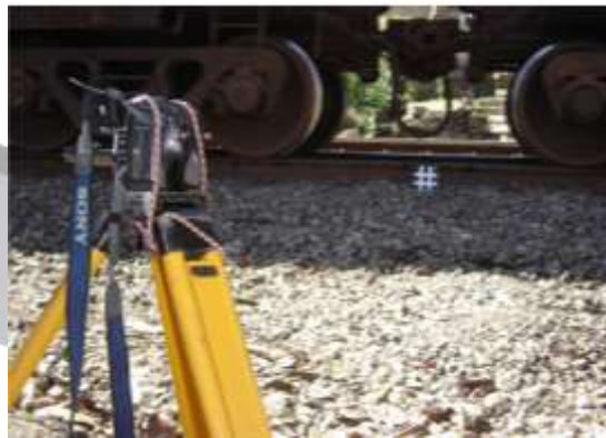
Figura 8 – Monitoração da deflexão no pavimento por meio de filmagem.
